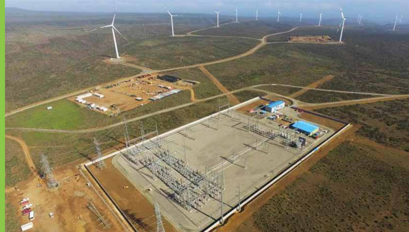
Movement at the (sub)station - Punta Sierra energised
